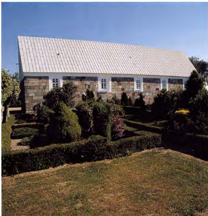
Gimsing Kirke ved Struer. Kirkebygningen er et langhus uden indspring i muren til kor.
