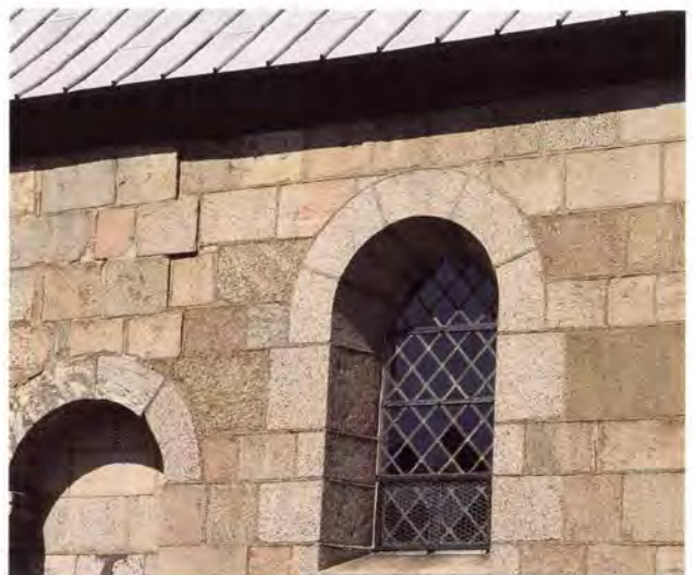
Sønderbæk Kirke. "Samlesæt" af ensartede sten tilført fra et stenbrud er blevet anvendt ved indramningen af de nye (store) vinduer.
