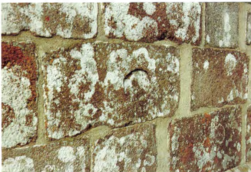
Lavklædt nordvæg i kvaderstenskirke. Bevoksning af lav, lichener og mos kan vanskeliggøre bestemmelsen af kvaderstenenes petrografi. (Foto: Forfatteren).
