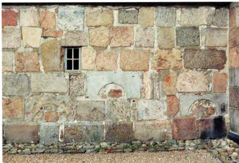
Genbrug af monoliter, der har dannet vinduesbuerne over de oprindelige små vinduer, som bygningssten i våbenhuset. Krage-lund Kirke. (Foto: Forfatteren).
